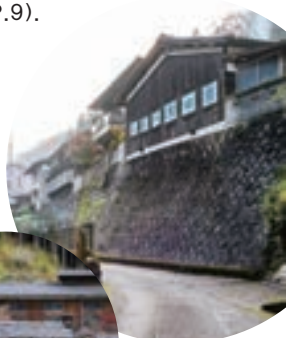
돌담과 고풍스러운 꺾죽이 인상적인 녹차공장· 녹차도매상이 즐비한 유야다니 취락
